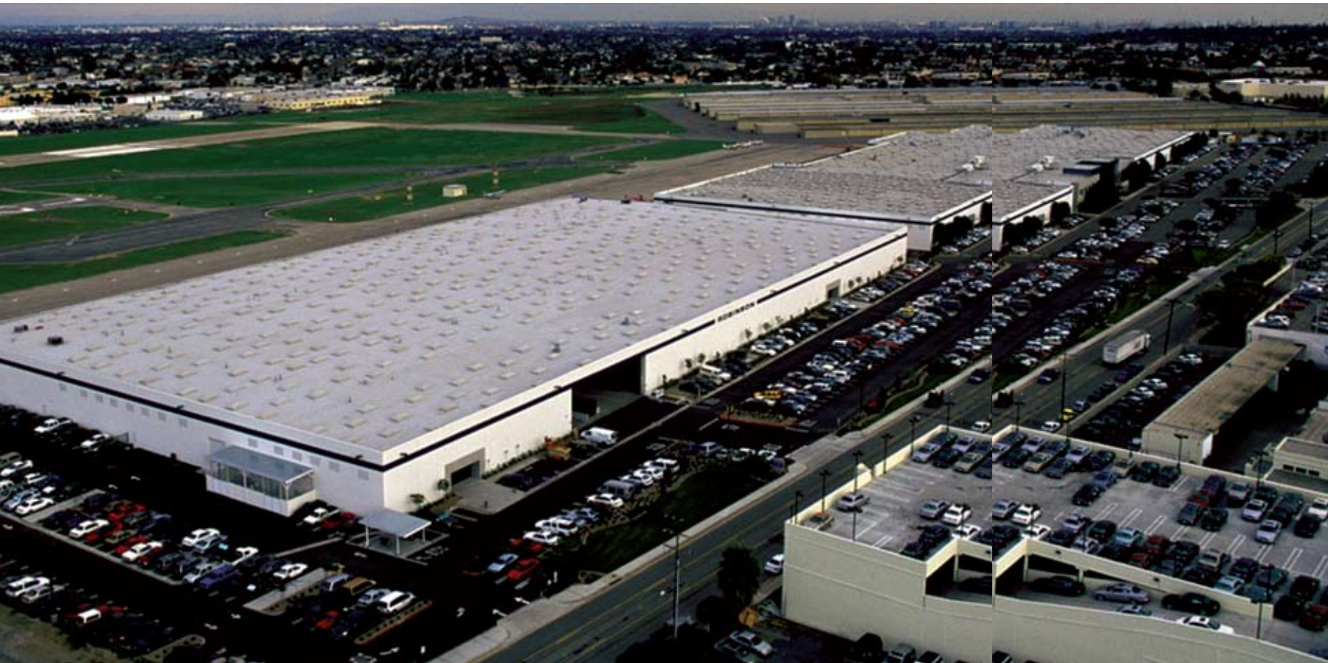
ภาพถ่ายจากภายนอกของโรงงานเฮลิคอปเตอร์โรบินสัน
